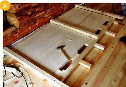
↑ Закрепив шурупами верхние поперечные бруски, установил по паре клиньев над каждым нижним поперечным бруском. Подбивая поочерёдно клинья, равномерно стянул сплачиваемые элементы.
