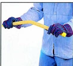
Чтобы избежать излома трубы во время гибки, в неё вставляют гибочную пружину или просто насыпают песок, который предварительно нагревают до температуры примерно +80°C. Засыпаемый в трубу песок тщательно уплотняют. Концы наполненной песком трубы закрывают пробками или колпачками.
