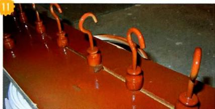
↑ Крючки для крепления светильника и фарфоровые изоляторы для ретропроводки окрасили в коричневый цвет.
