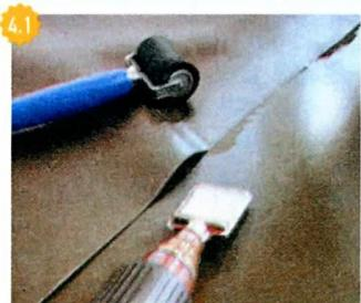
**4.1** Стыки между полотнами плотной гидроизоляционной плёнки сваривают с помощью строительного фена, оснащённого специальной насадкой.
