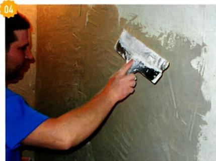
↑ Нанесение базового слоя самодельной «венецианской» штукатурки.
