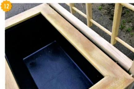
↑ Съёмную крышку прикрепил к нижней перемычке шпалеры на шканты без клея.
