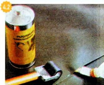
**4.2** Можно сварить стыки и холодным способом с использованием химических средств, специально предназначенных для этого.
