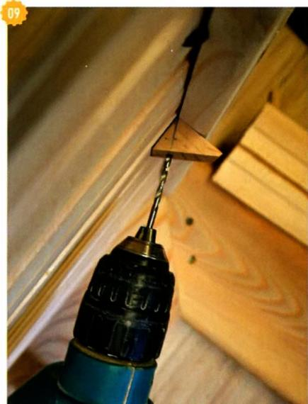
09 ↑ При сверлении отверстий под саморезы использовал приспособление из древесины.
