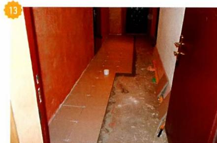
↑ Укладка напольной плитки из керамического гранита.
